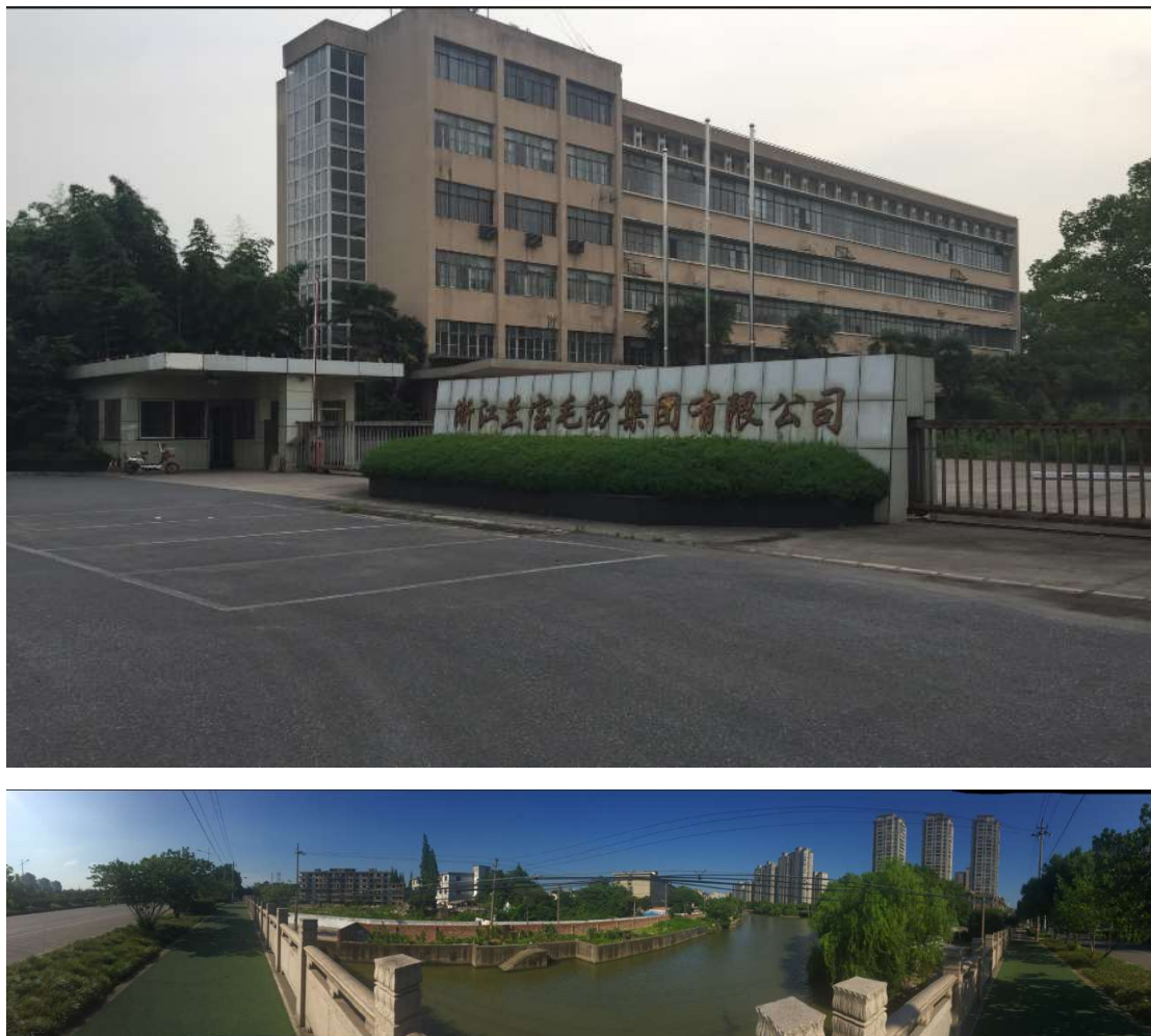
图 3.2.1-1 嘉兴市湖滨片区兰宝地块现场照片
