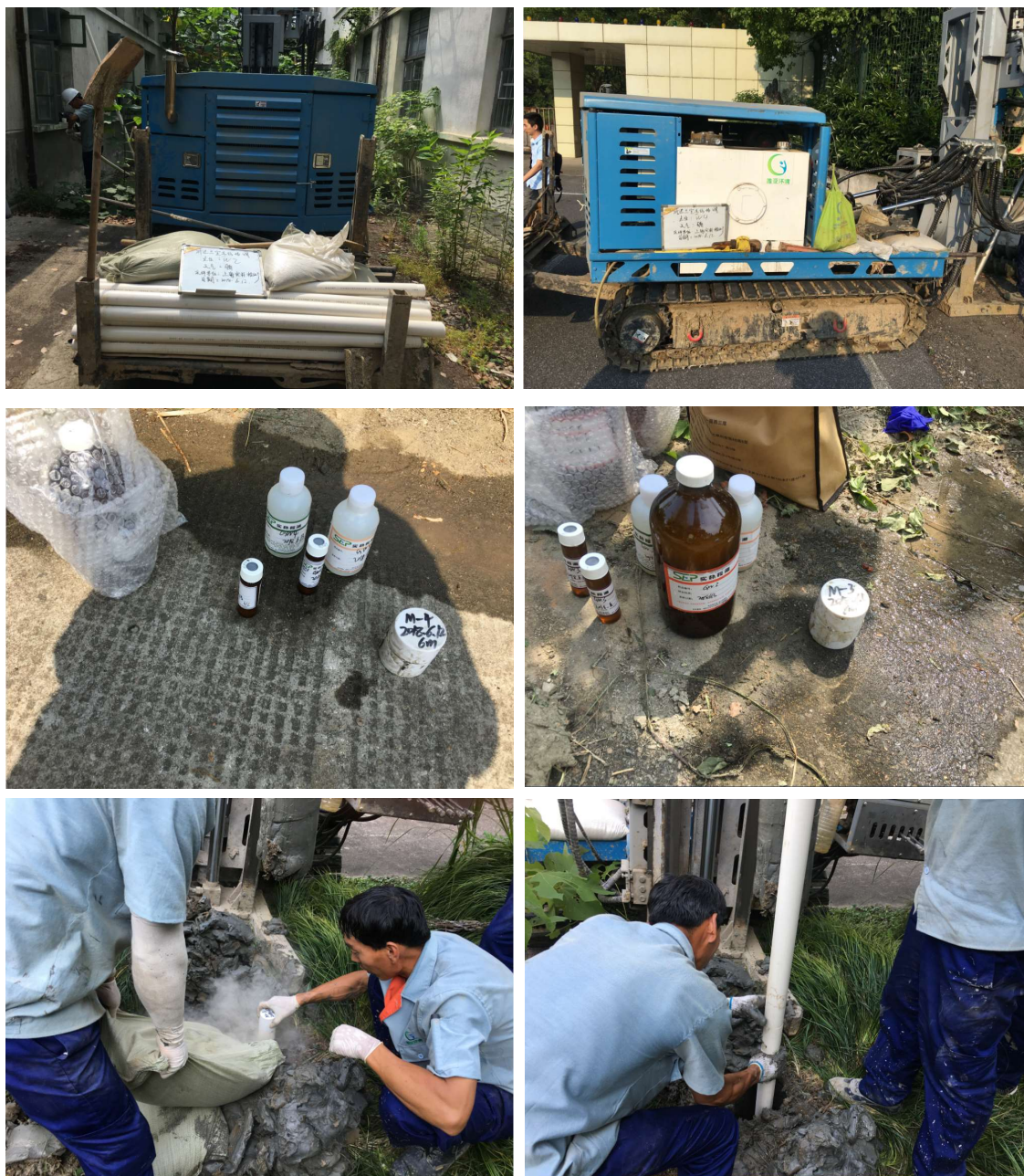
图 4.4.2.3-1 目标地块调查地下水监测井建井及地下水采样
