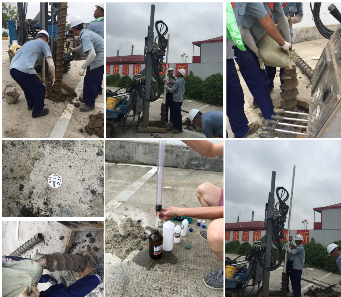
图 4.4.2.3-1 目标地块调查地下水监测井建井及地下水采样
